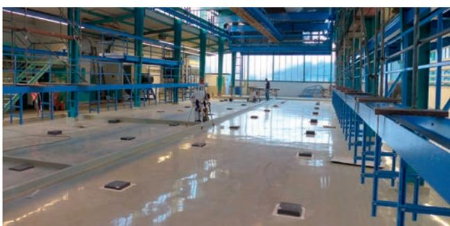
WHG Beschichtung eines Auffangraums in einem Galvanikbetrieb
