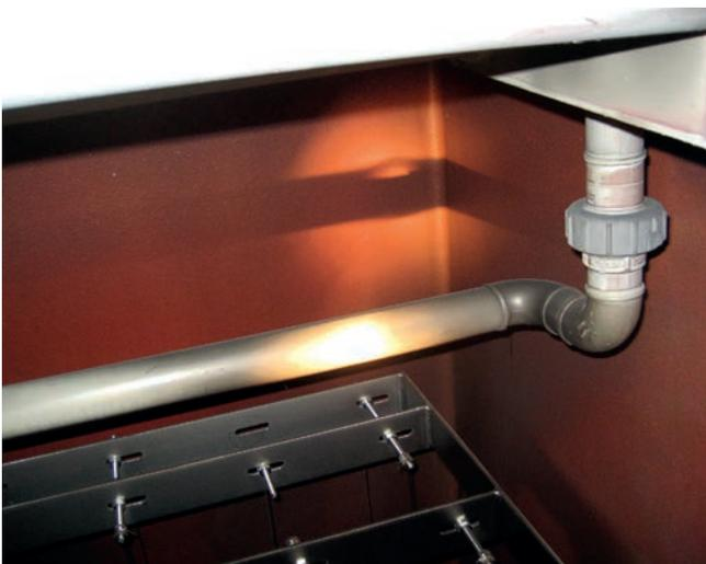
COROFLAKE Beschichtung in einem Nasselektrofilter
