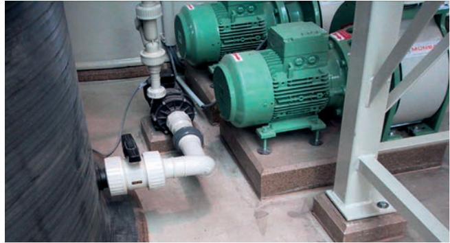
Polybetonsteine als Pumpen- und Apparatfundament
