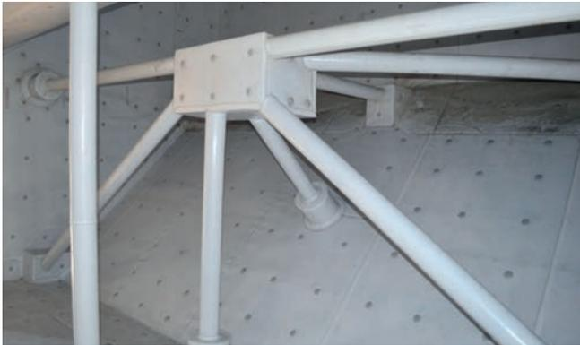
PFA Auskleidung in einem Rohgaskanal
